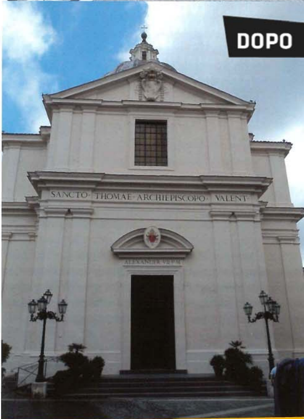
LA FACCIATA DELLA CHIESA DI SAN TOMMASO DA VILLANOVA PRIMA E DOPO I LAVORI DI RESTAURO.
